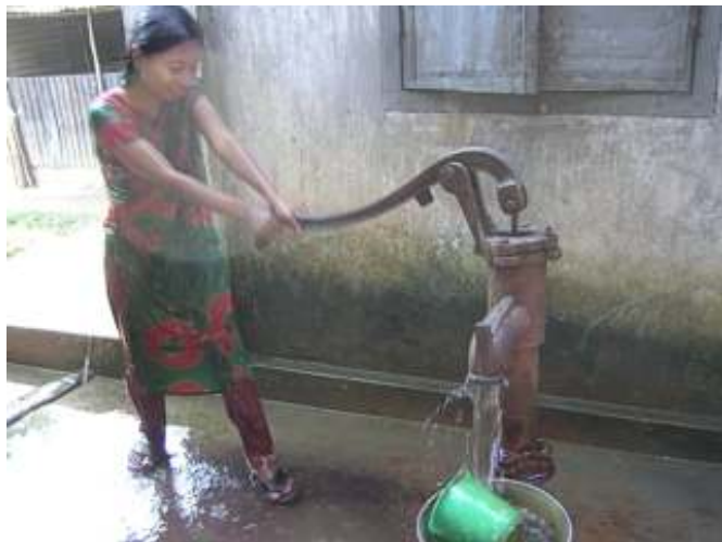
Pompe sur forage dans la communauté des sœurs
